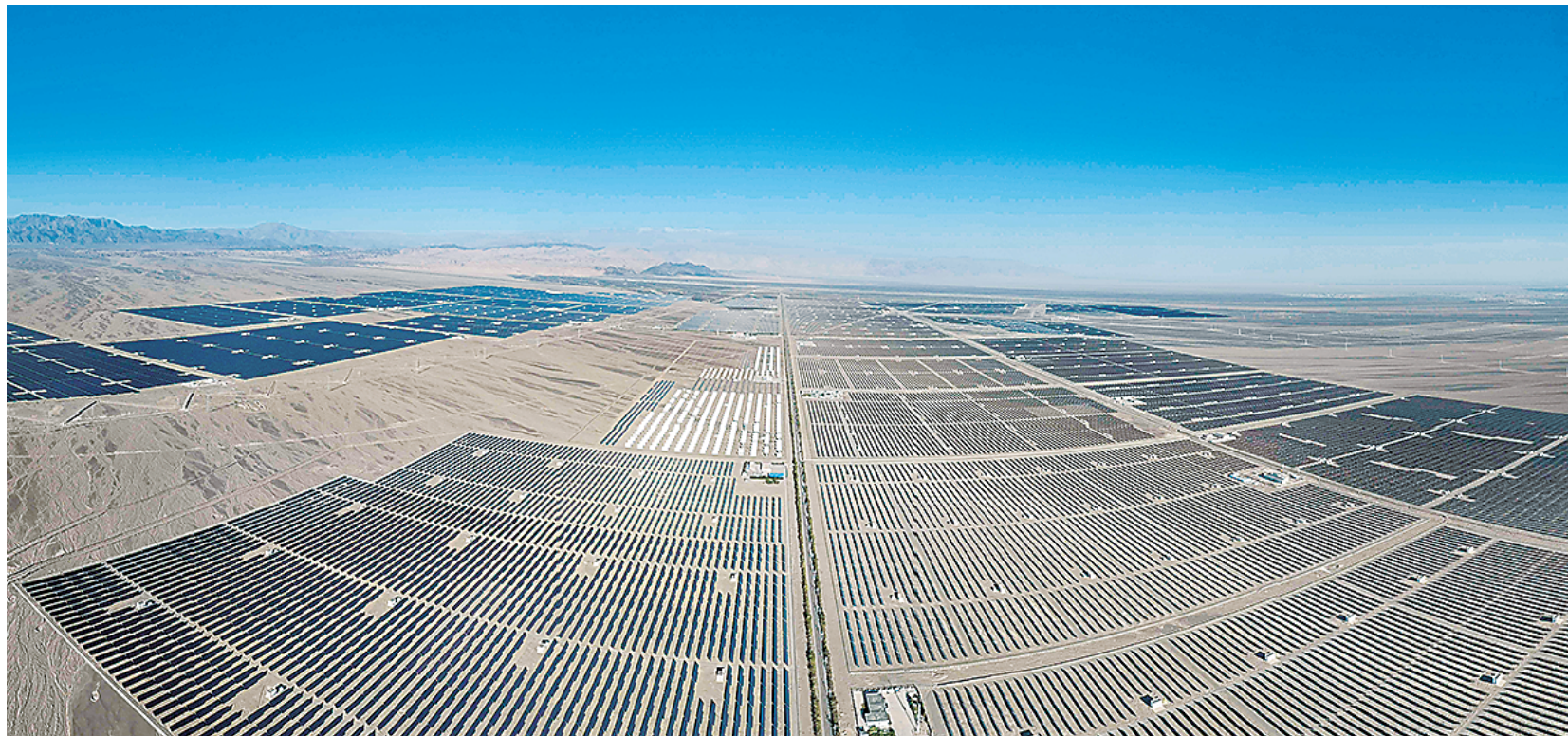
这是9月9日拍摄的新疆哈密市石城子光伏产业园(无人机全景照片)。
