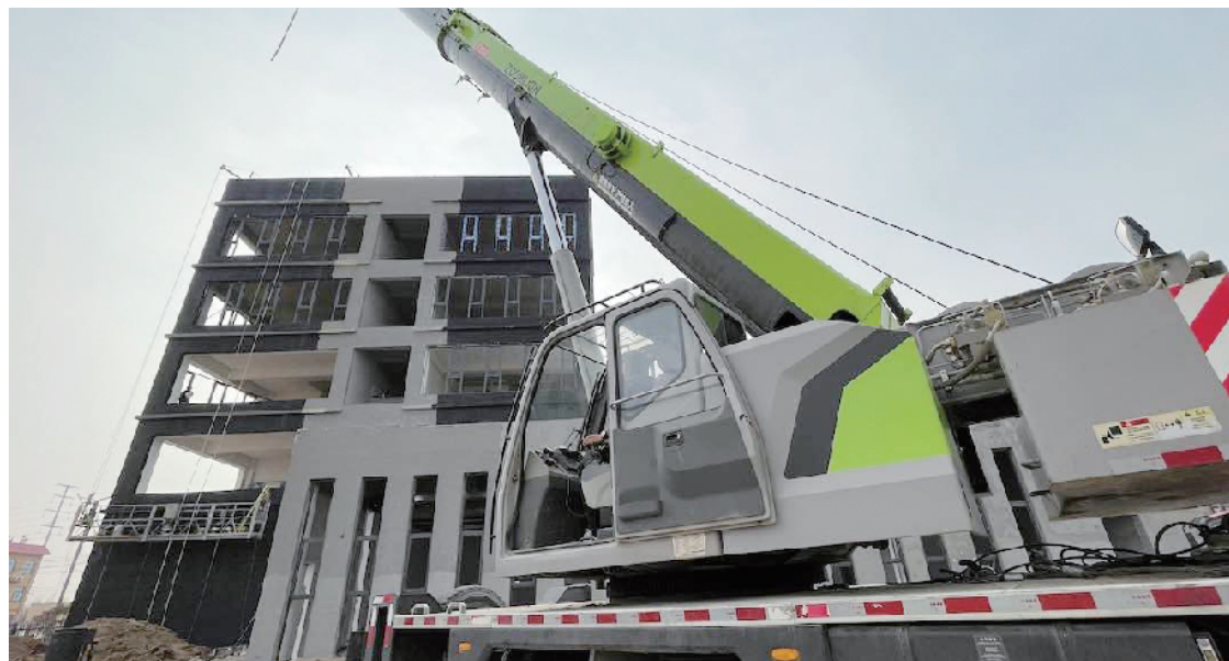
明仁苏打水项目建设现场。
